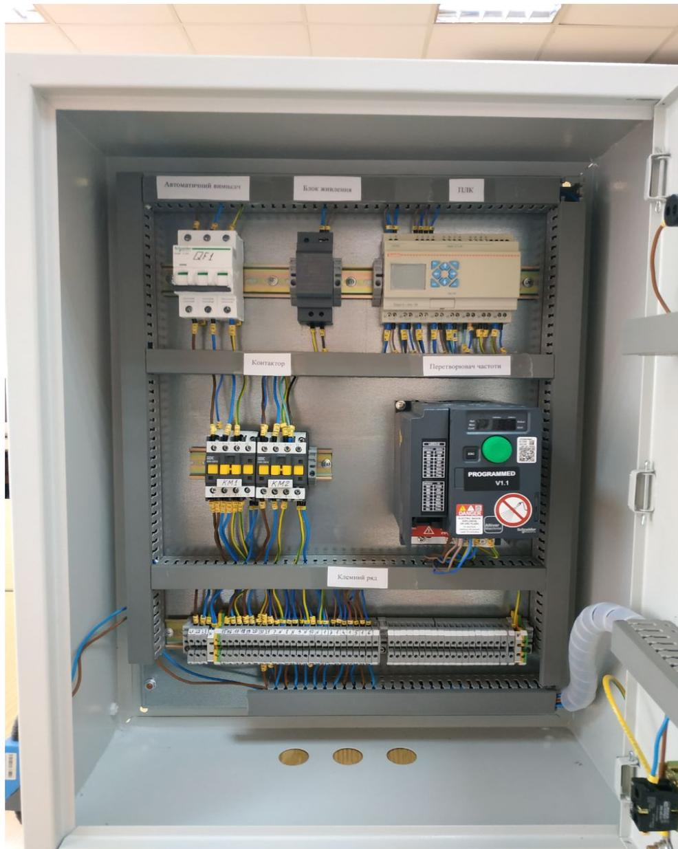
1. Автоматичний вимикач Schneider Electric C16
